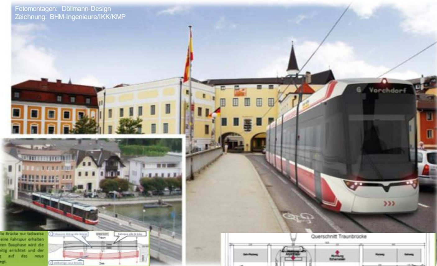
Zunächst wird die alte Brücke nur teilweise abgetragen, sodass eine Fahrspur erhalten bleibt. In der nächsten Bauphase wird die neue Brücke halbseitig errichtet und der Verkehr einspurig auf das neue Halbtragwerk umgelegt.
